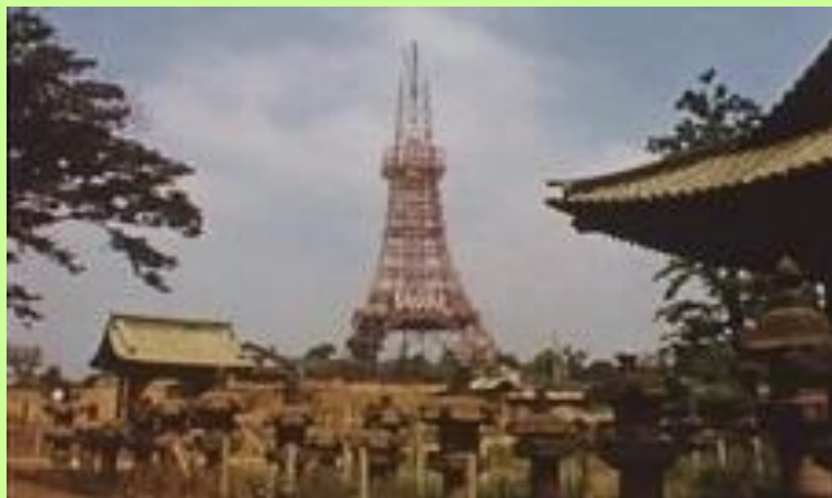
『偉大なる建設 東京タワー建設記録』
